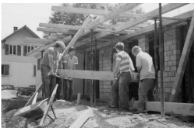
Das alte FC-Hüttli (mit Türu Lohri) und die Baustelle des unteren Teils des heutigen Clublokals 1984.
